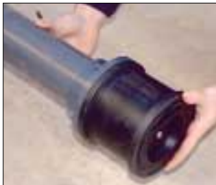
2. Přiložte tělo klapky k nákrůžku
